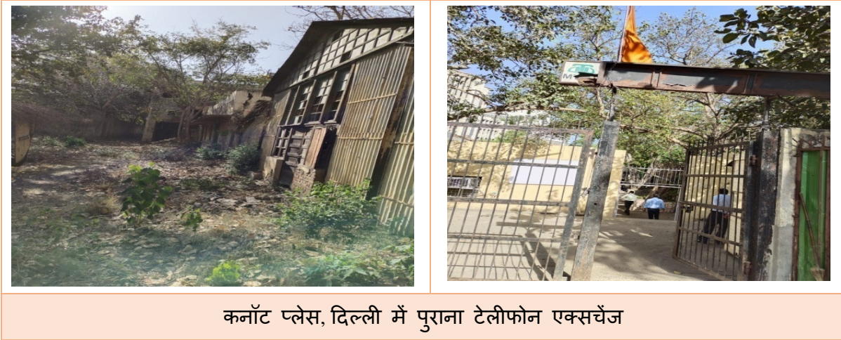
चित्र 5.1: कनाॅट प्लेस, दिल्ली में पुराना टेलीफोन एक्सचेंज भवन
